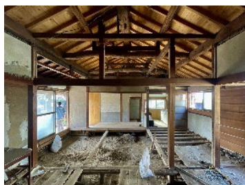
古民家改修現場
